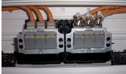
Bei Kanal- und Unterflurmontage ist darauf zu achten, dass die Kabelzuführung so flach wie möglich gehalten werden kann. Dies garantiert die Einhaltung der zulässigen Biegeradien. Auf eine Trennung zwischen Elektro- und Datenverkabelung ist zudem zu achten.
