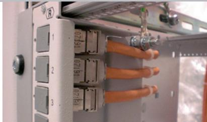
Im Verteilerbereich spielt neben der normgerechten Kabelzuführung und Schirmung auch die Servicefreundlichkeit eine große Rolle. Hier bieten Schubladenausführungen den gewünschten Komfort und modulare Lösungen zudem den Vorteil, defekte Ports im laufenden Betrieb problemlos tauschen zu können, während die restlichen Strecken in Funktion bleiben.
