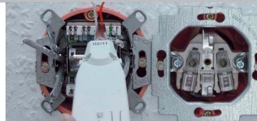
Steht keine größere Up-Einbaudose zur Verfügung, bieten durchgängig von vorn montier- und anschließbare Daten-dosen Vorteile. Durch geringere Anschlusslängen werden Kabelüberlängen in der Dose vermieden und die Platzverhältnisse so optimal genutzt.
